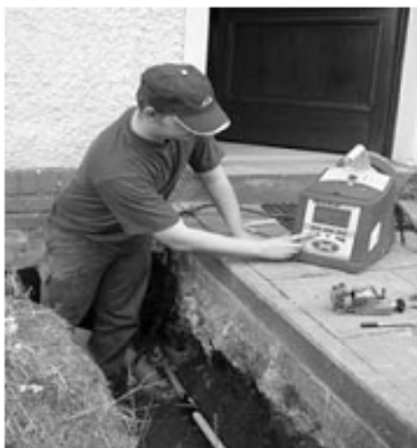
Рис. 10. Ввод данных посредством клавиш сварочного аппарата FRIAMAT.
