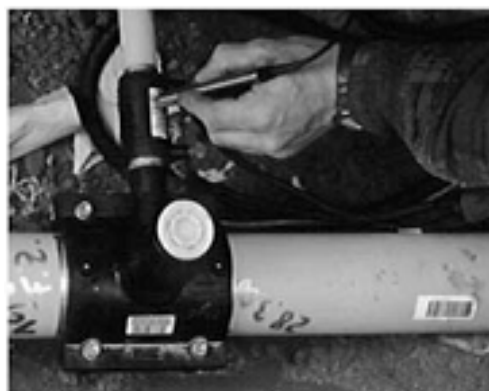
Рис. 7. Считывание параметров режима сварки и данных обратного отслеживания.
